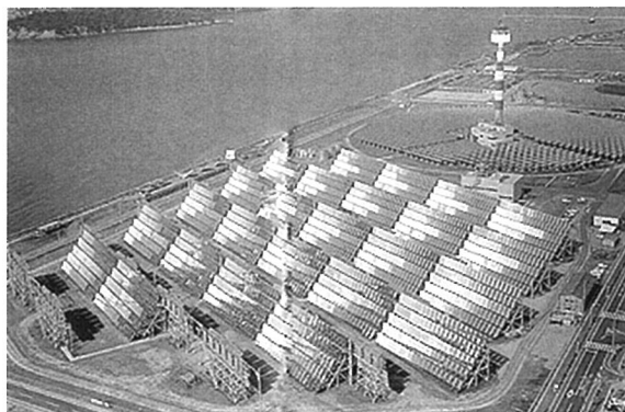
太陽熱発電所
